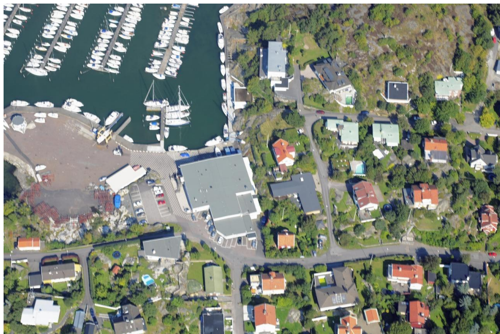
Pejlingsgatan 13 – Snedbild från söder
