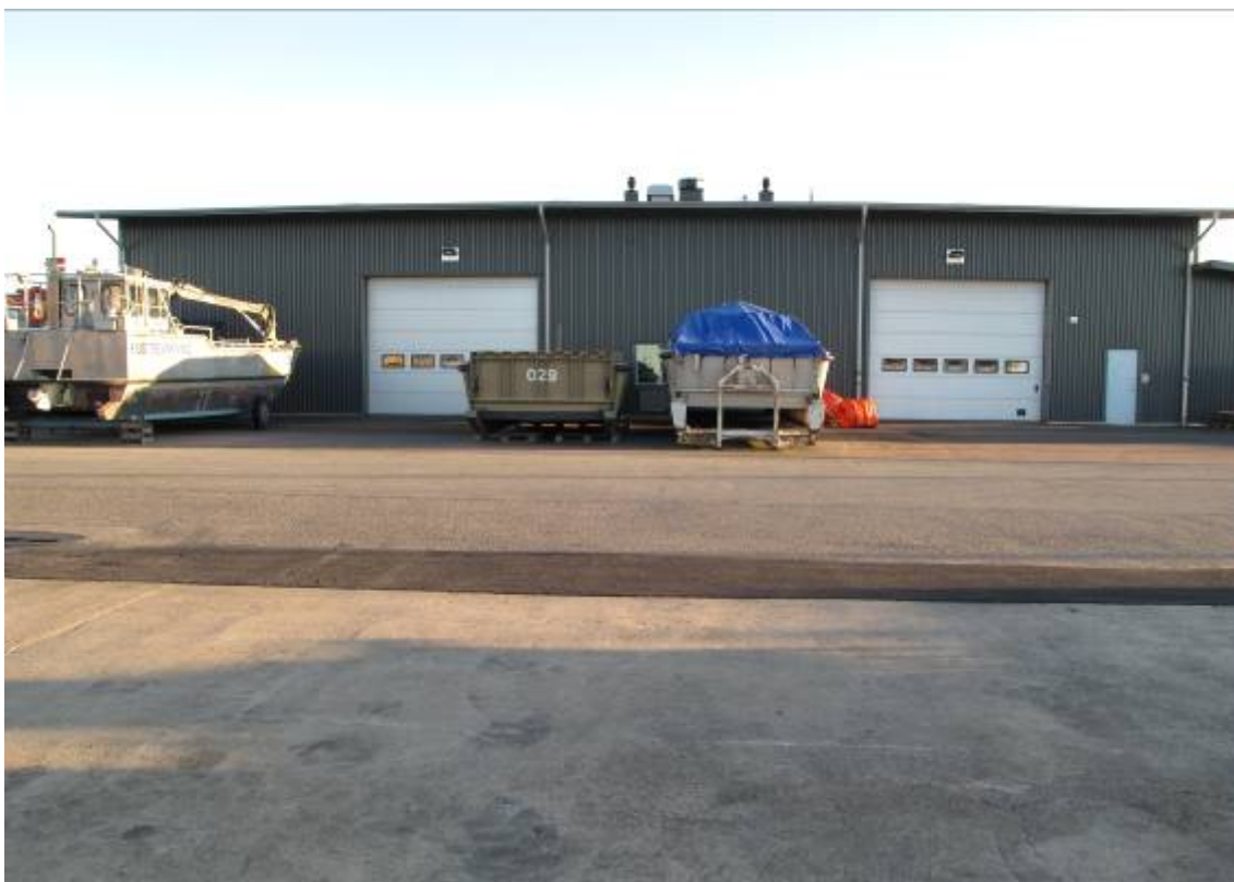
Miljöhallen från norr
